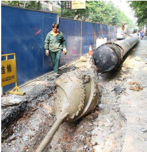
全气压顶管的工具管大多为手掘式, 挖土的多用人工, 工具管结构较复杂。施工效率很低, 只为普通手掘式顶管的30%~50%, 有钢制的气压舱也有混凝土控制的气压舱。全气压式: 发掘面上和管道内一切工作人员都在气压条件下任务, 整个顶管管道内都充溢一定压力的压缩空气。部分气压式: 压缩空气只作用在发掘面上, 于全气压施工而言, 操作人员在常压下任务。气压施工的特殊要求1、对土质的要求: 渗透系数大于 $1\times 10^{-2}$ cm/s的砂砾层中, 因透气性大, 且地下水多, 漏气很凶猛, 不宜采用。点我: 送工程适用干货。2、对环境的要求: 设备多, 占地较大, 空压机噪音很大, 不宜在居民密集区采用。3、对作业人员的要求: 必需是经过训练的专业人员, 身强力壮。优点: 均衡压力的调理和排泥零碎的排量是截然分开的, 互不干扰, 可更精确的调理均衡压力, 特别是非平均地层中施工。技术人员要积极参与到导向钻孔工作中。淮安非开挖顶管工程公司非开挖技术是对地下工程施工常规工法的重要补充。
